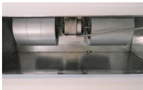
DC Motor Fan Coil Units
