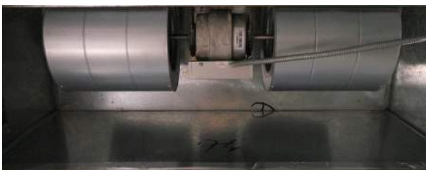
DC Motor Fan Coil Unit
